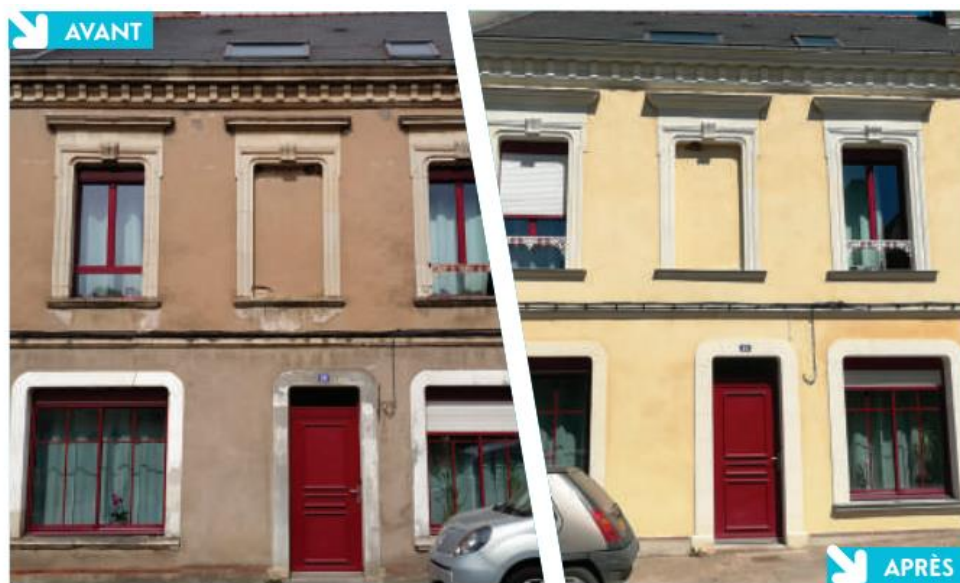
Opération propre à CCVHA : rénovation de façade (extrait plaquette d'information OPAH)
