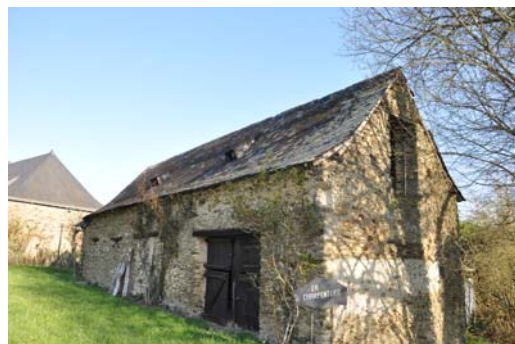
Patrimoine rural - La Charpenterie
