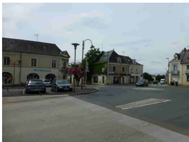
Ordonnancement du bâti autour de la place de l'Eglise et de ses artères principales
