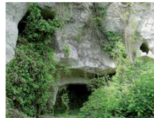
DÉFAUT D'ENTRETIEN DE LA VÉGÉTATION
