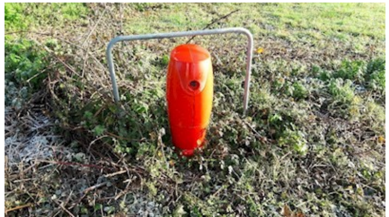
Photo de l'hydrant
