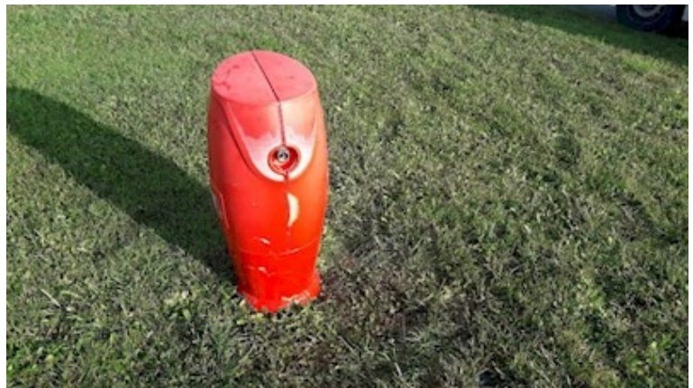
Photo de l'hydrant
