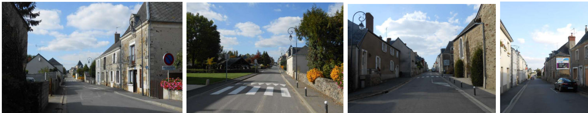
Rue Max Richard : rue principale présentant un caractère très urbain marqué par un front bâti quasi continu
