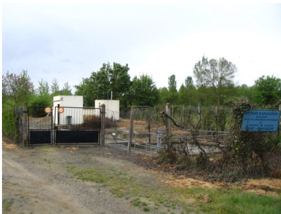
Station de traitement
