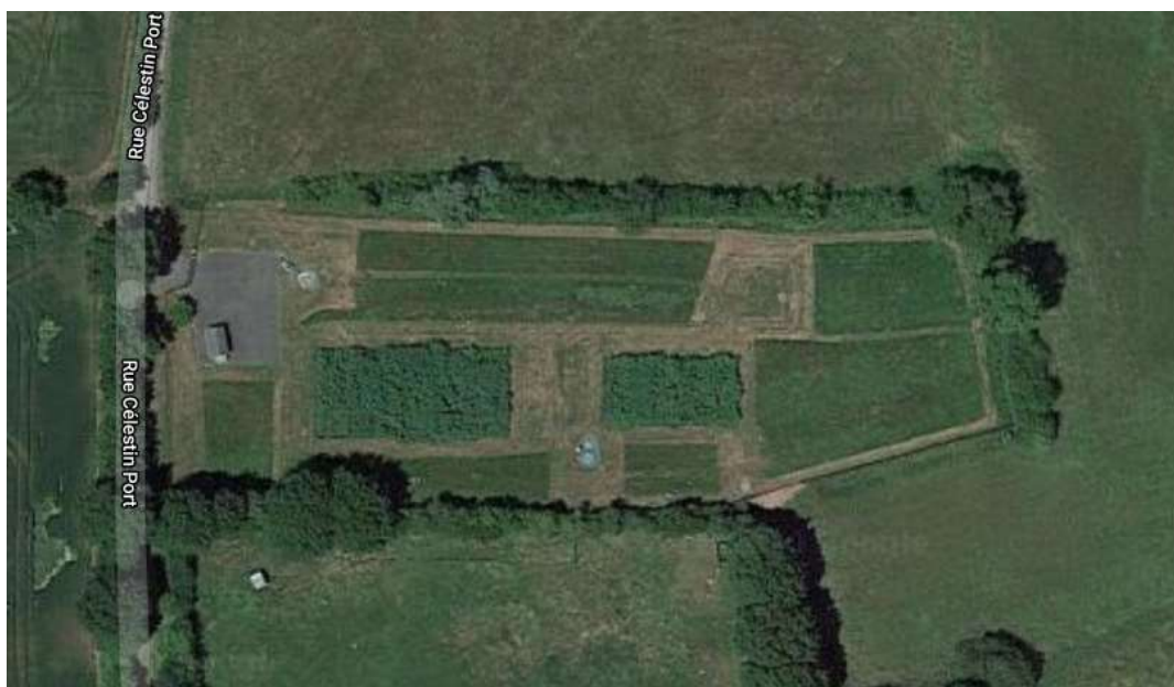
Station de traitement
