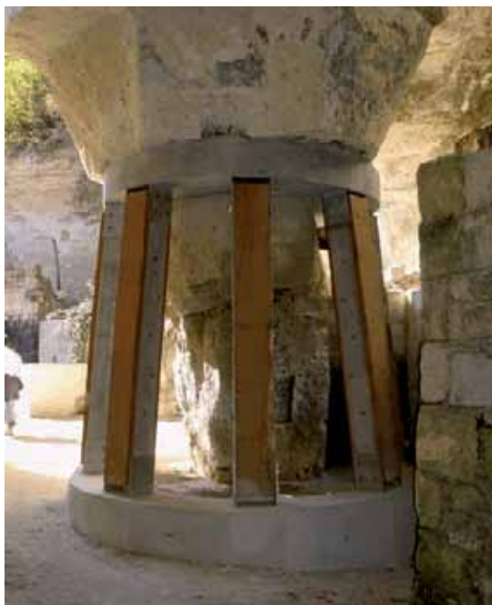
CONFORTEMENT DE PILIERS, À SOUZAY-CHAMPIGNY
