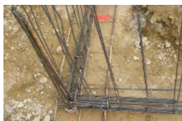
Noeud de chaînage - Continuité mécanique
