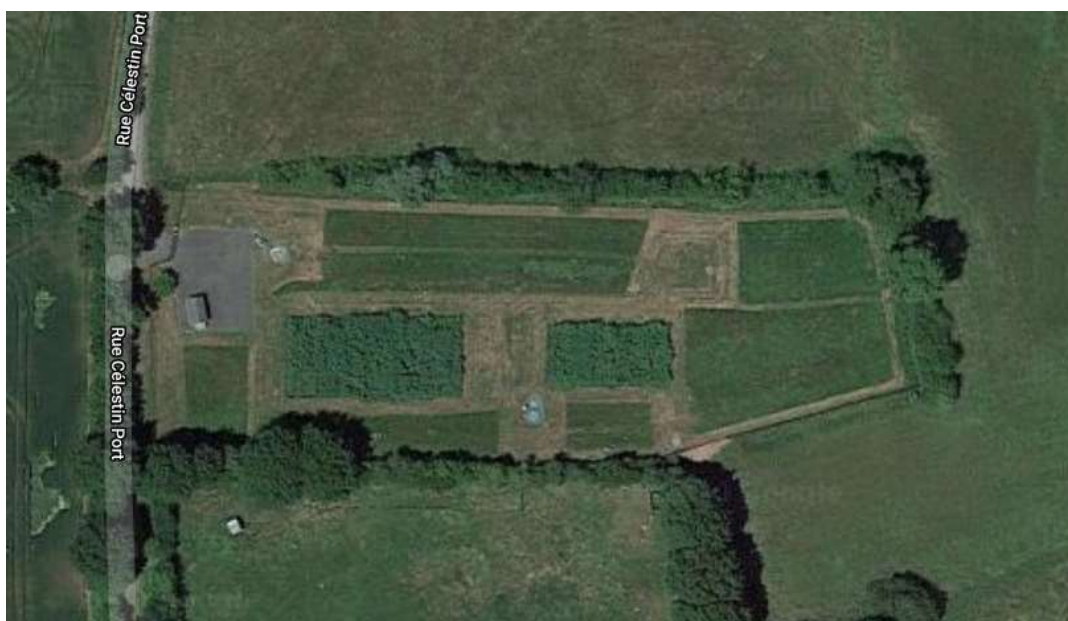
Station de traitement
