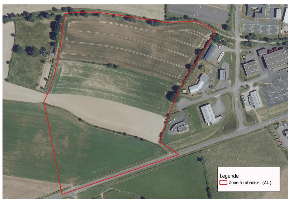
Figure 4 : vue aérienne de la zone 1AUY
