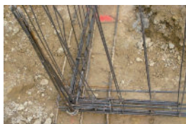
Noeud de chaînage - Continuité mécanique
