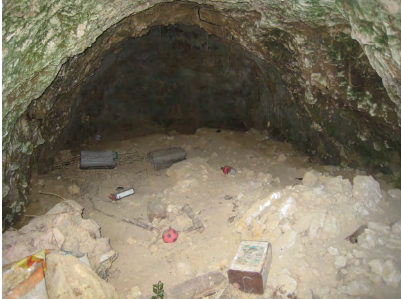
Photo 2: Vue de l'intérieur de la cavité avec quelques chutes de pierres en toit (Ind. 003)
