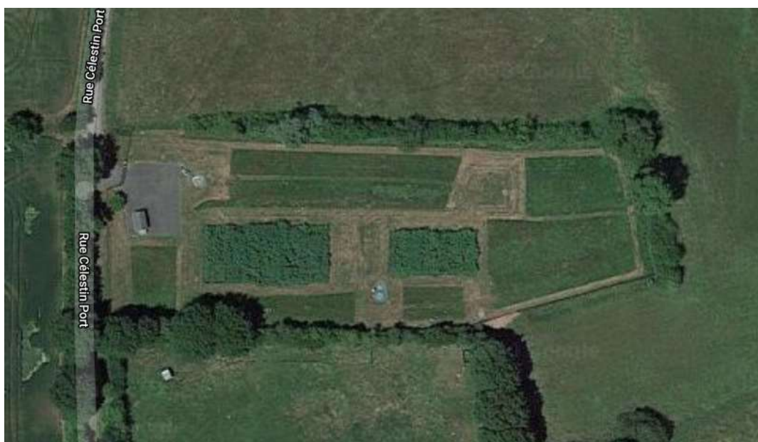
Station de traitement
